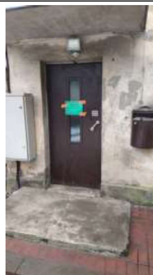
Kāpņu telpas ārdurvis
